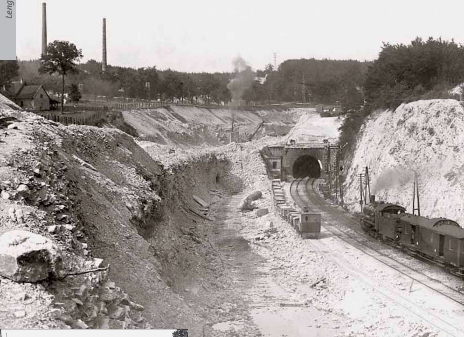
Der neue Lengericher Tunnel entsteht. Aus Kostengründen wurde er 181 m kürzer als der alte, der südliche Einschnitt entsprechend länger. Nach Fertigstellung des neuen sollte der alte Tunnel auf dessen Länge gekürzt werden. Der abgetragene Kalkstein der neuen Einschnitte und das Ausbruchsmaterial aus dem Tunnel wurden ca. sechs Kilometer weiter südlich im Bereich des Überholungsbahnhofes Ringel seitlich des Bahndamms abgekippt bzw. angefüllt. Eine Feldbahn führte zu diesem Zweck parallel zur „Rollbahn“ auf deren Westseite dorthin. Stadtarchiv Lengerich (4), DGEG-Archiv
