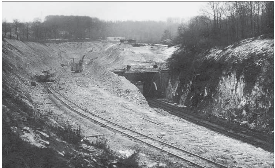
Der neue Lengericher Tunnel entsteht. Aus Kostengründen wurde er 181 m kürzer als der alte, der südliche Einschnitt entsprechend länger. Nach Fertigstellung des neuen sollte der alte Tunnel auf dessen Länge gekürzt werden. Der abgetragene Kalkstein der neuen Einschnitte und das Ausbruchsmaterial aus dem Tunnel wurden ca. sechs Kilometer weiter südlich im Bereich des Überholungsbahnhofes Ringel seitlich des Bahndamms abgekippt bzw. angefüllt. Eine Feldbahn führte zu diesem Zweck parallel zur „Rollbahn“ auf deren Westseite dorthin. Stadtarchiv Lengerich (4), DGEG-Archiv
